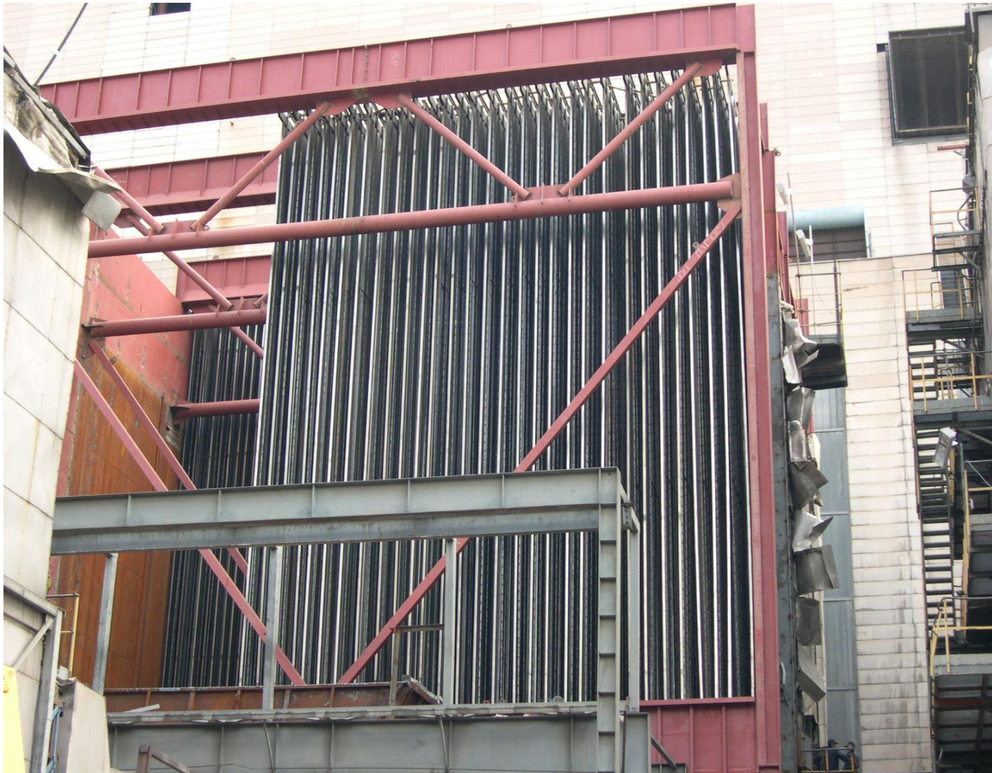
Deo ESI postrojenja na TENT-A4/ Elektrodni sistem
