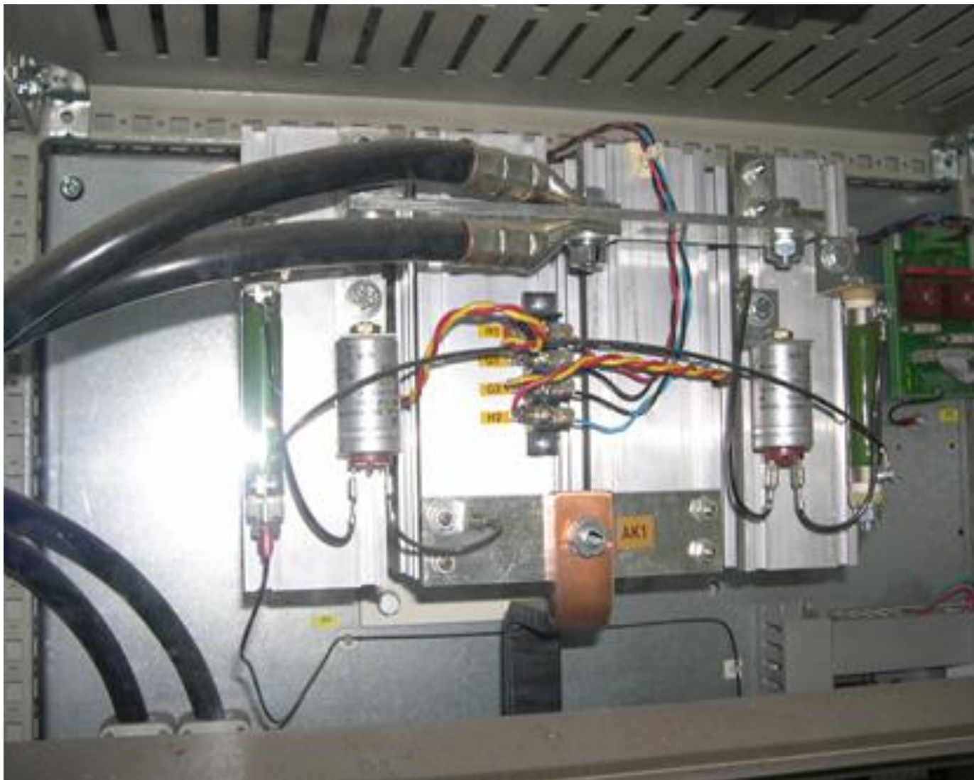
Tiristorski (SCR) blok sa zaštitnim elementima i sistemom za hlađenje
